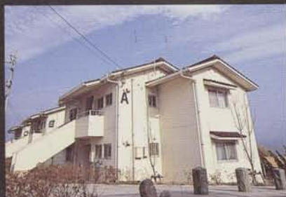
公営住宅の建設
