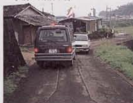
工事前の南後平線
