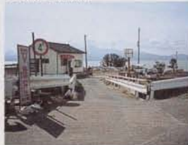
工事前の平原橋
